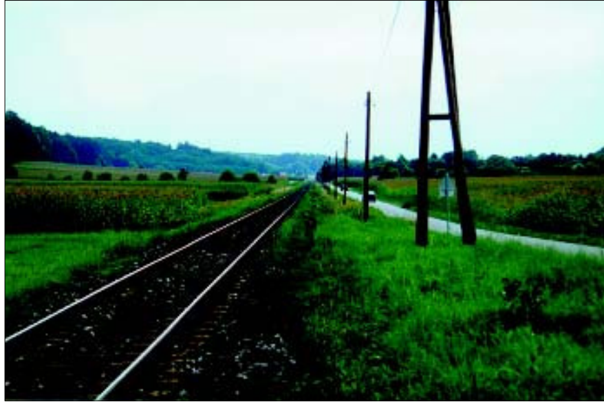
Abb. 2: Untersucher Bahndammabschnitt in Leitersdorf, Safental 18. 8. 1998. Foto: L. Zechner.
