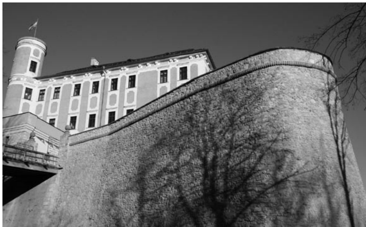
Südwest-Bastei saniert, 9.11., Foto: UMJ, K. Krenn
