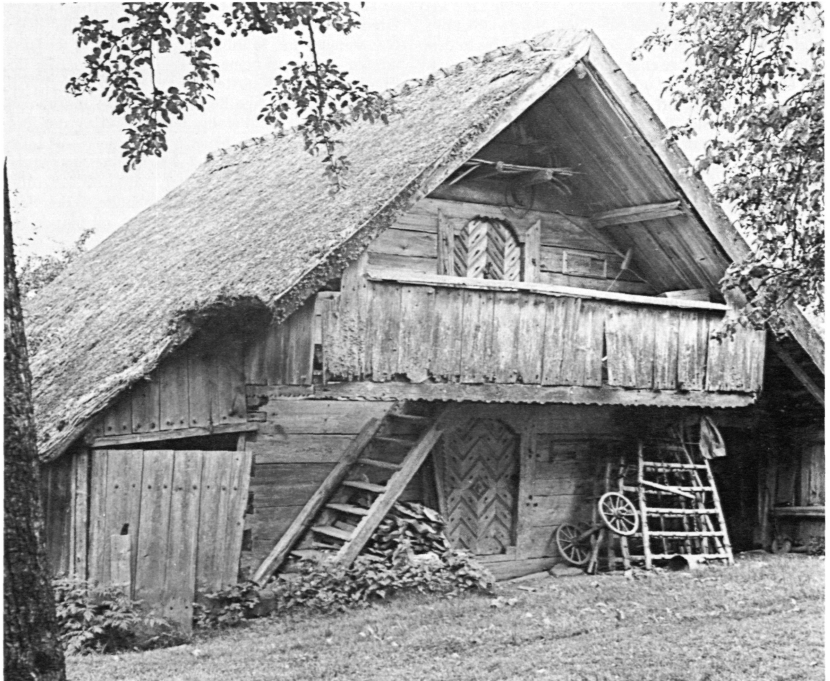
Kastenspeicher aus Altendorf, Gemeinde Sarleinsbach, Bezirk Rohrbach
