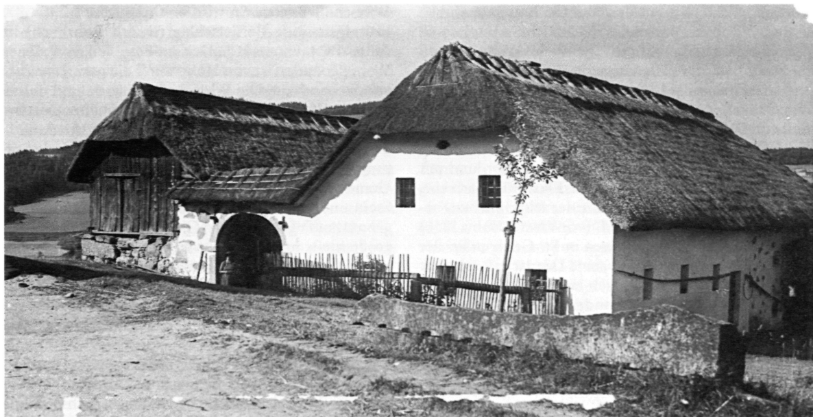
Dreiseit- oder Tormauerhof aus Ennsedt, St. Leonhard bei Freistadt, Bezirk Freistadt
