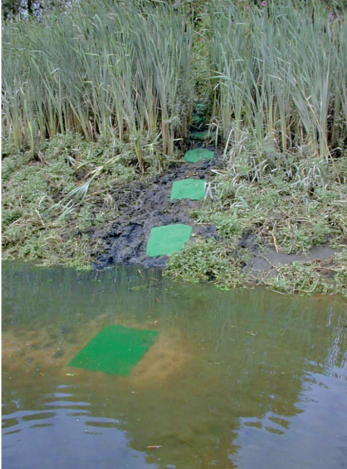
Abb. 5.1-1: Ausbringen der Sedimentationsmatten im Priel Overhaken am Südufer.
