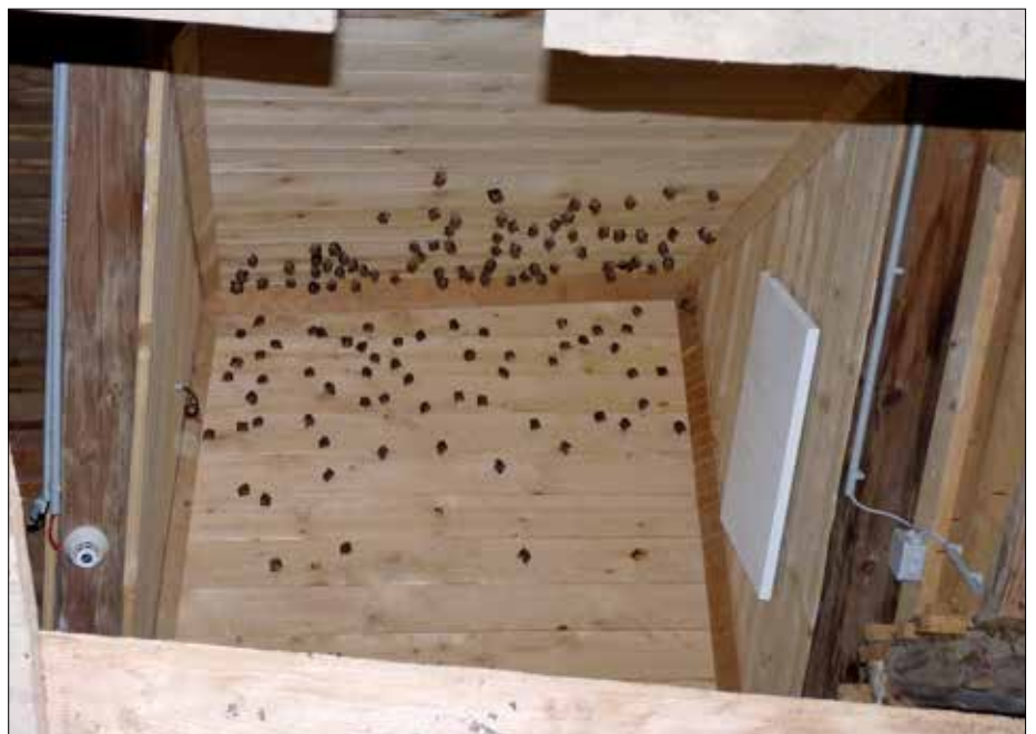
Blick auf den neu geschaffenen und mittels Wärmeglocke optimierten Hangplatz der Kleinen Hufeisennasen im Dachboden der Propstei St. Gerold. Rechts ist die Heizplatte zu erkennen. © Hans Walser
