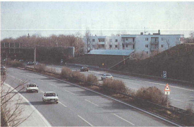
7 Grünbrücke an der A 96 – Bereich Blumenau
