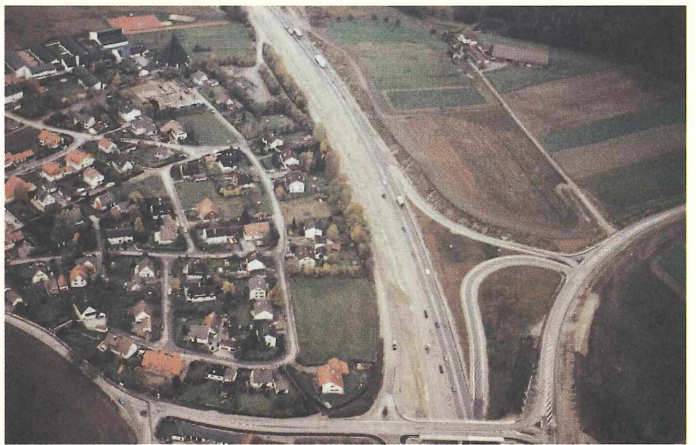
14 Baustelle der A 96 im Bereich Windach
