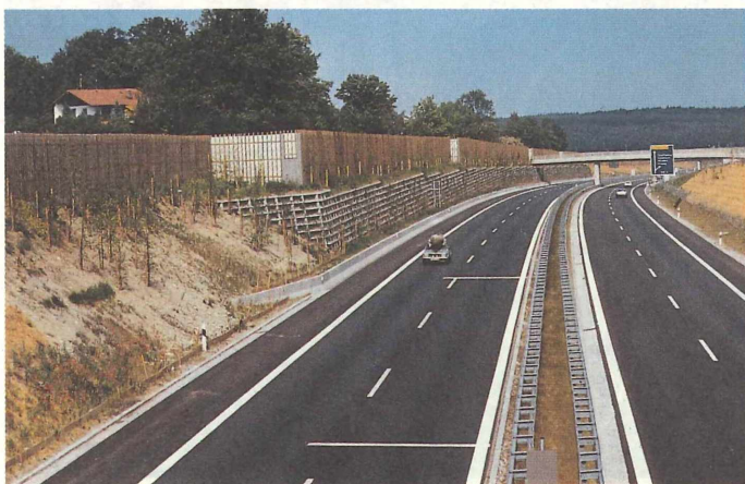
17 Lärmschutzwand Schöffelding im 1. Sommer nach der Fertigstellung
