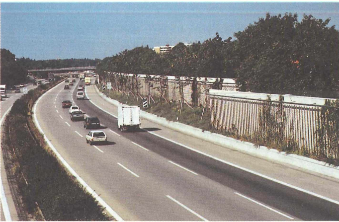
6 Lärmschutzwand Blumenau an der A 96
