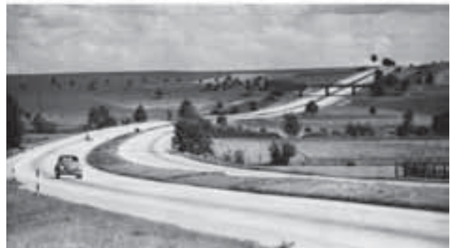
Abbildung 12: Abrupter Wechsel von Kreisbögen und Tangenten (oben). Im Gegensatz dazu ein kontinuierliches, durchschwingendes Fahrband (unten) (Fotos: Hans Lorenz, in TUNNARD u. PUSHKAREV 1981, 200)
