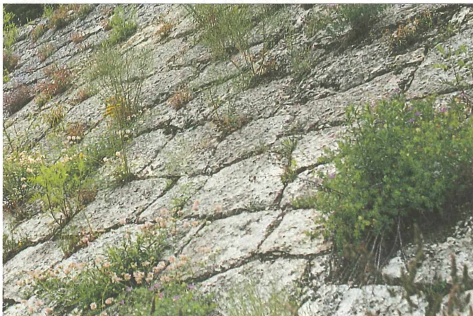
6: Stützmauer einer Eisenbahnlinie bei Matting, Landkreis Regensburg, aus groben Steinblöcken. Die dabei entstehenden tiefen Fugen sind insbesondere für Kriechtiere (Reptilia) von Bedeutung.
