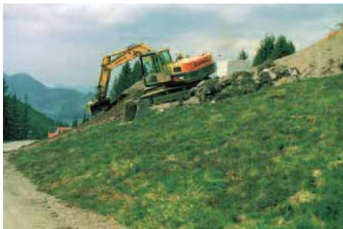
Abbildung 9 Errichtung eines Güter- und Schiweges bzw. Abfahrtbau mit dem Bagger.
