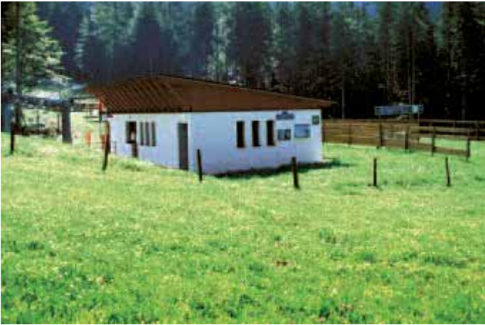
Abbildung 2 Latschenalm Talstation 13 x 28 m, ungefähr 350 m 2 unterirdische Fläche; Lagerraum für 140 Sessel
