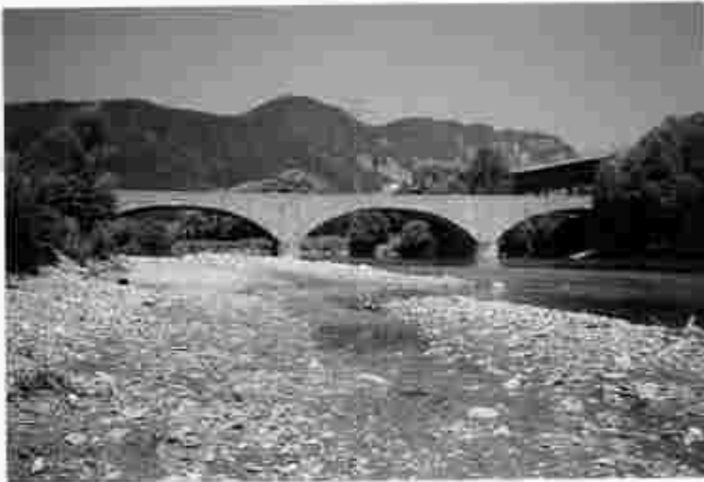
Abb. 20: Granitgnose des Humpelgrabens eingesetzt als Baumstein bei der Murbrücke Peggau - Deutsch Feistritz.
