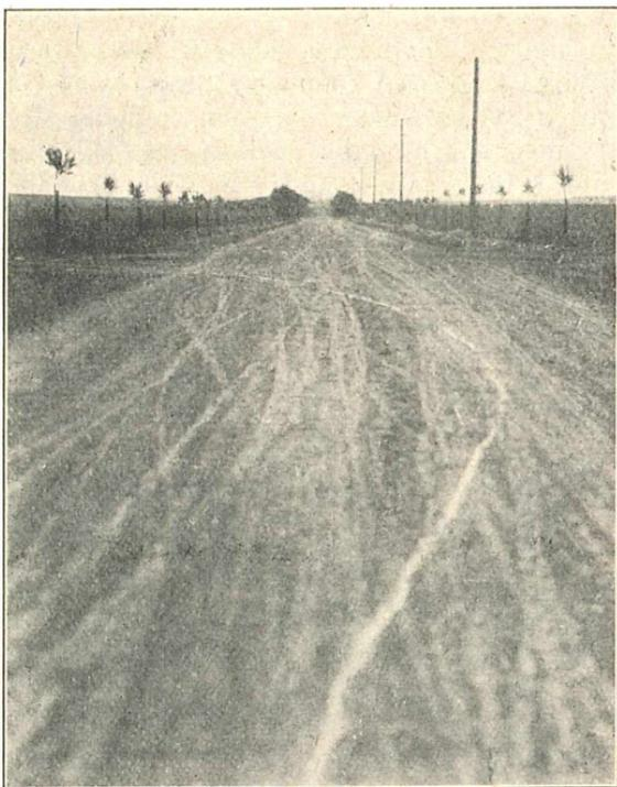
Fig. 9. Selbständiger Ausweichbogen der linken Hinterradspur eines mit einem 3jährigen, schweren (völlig führerlos gelassenen) Pferde bespannten, leichten, unbeladenen Wagens.
