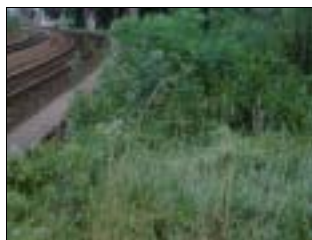
Bahndamm; Quelle: Büro Grimm
