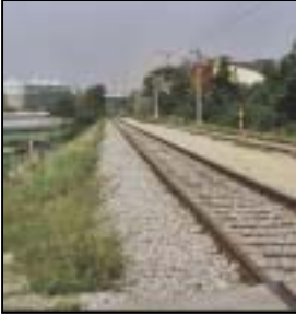
Gleise bei der Hallergasse; Quelle: Hysek, S.
