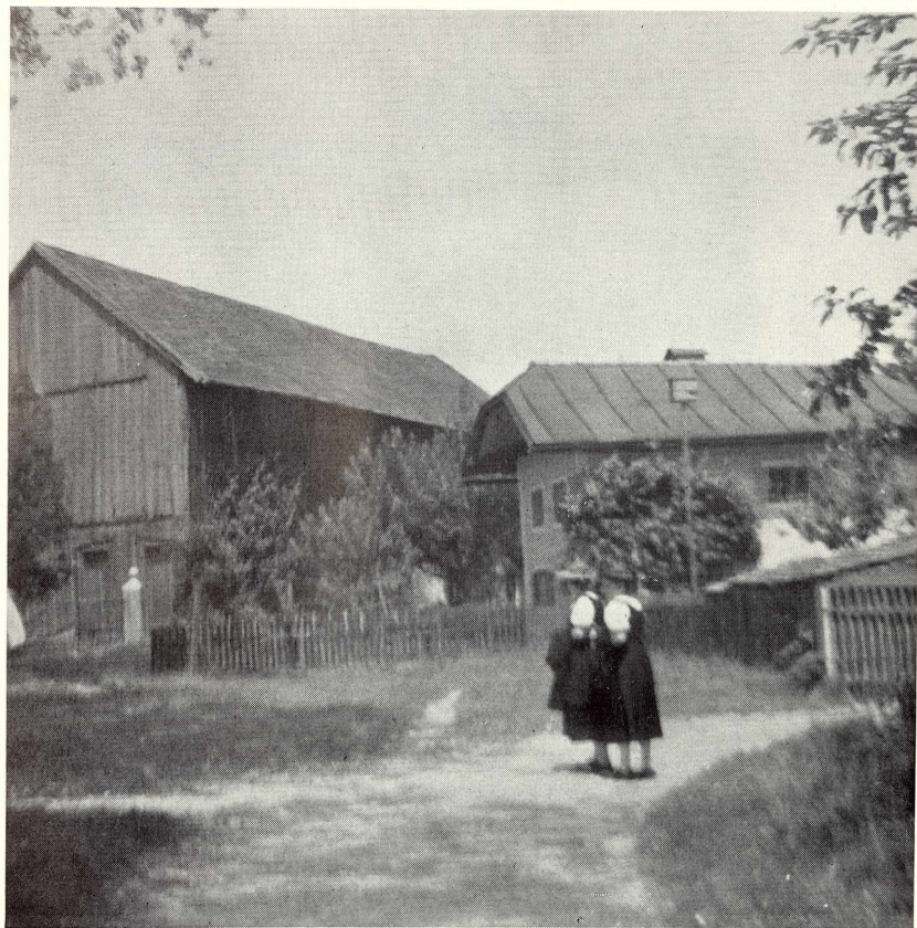
Bild 7. Ehemaliger Schopperstadel (links) und einstiges Schopperhäusl des Schoppermeisters Gastager in Laufingen.
