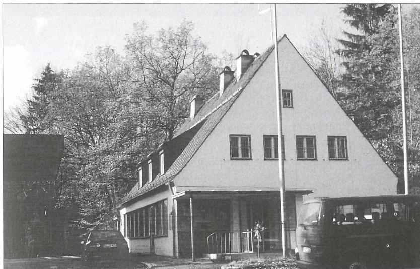
Abb. 13 Das Salzburger Landesarchiv bemüht sich, topografisch interessante Situationen oder Bauwerke, bei denen Veränderungen bevorstehen, fotografisch zu dokumentieren. So entstand 1999 eine Serie über die Zollhäuser an der bayerisch-salzburgischen Grenze. Das deutsche Zollhaus am früheren Grenzübergang Walserberg-Bundesstraße existiert bereits nicht mehr (Original [Fotosammlung F 3752] und Foto: SLA).
