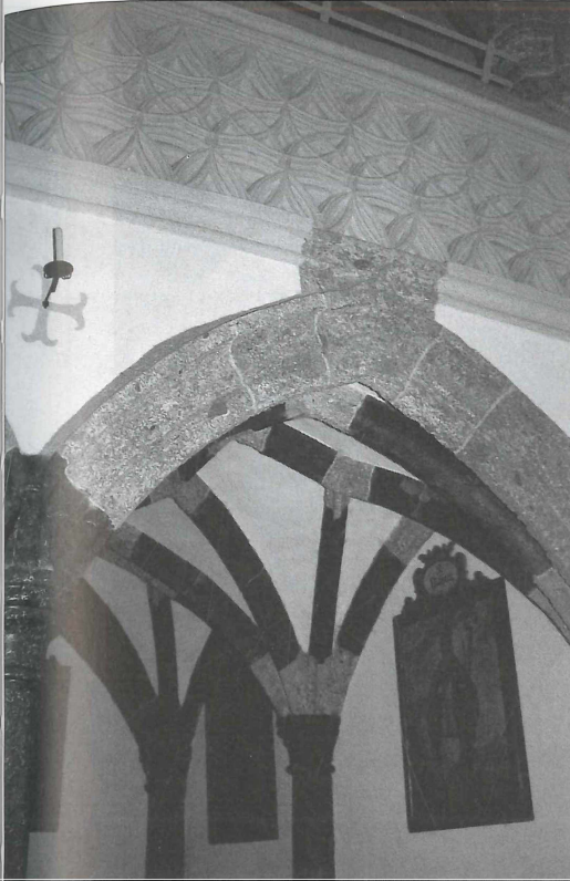
Abb. 4 (links) Georgenberg bei Kuchl, Fialkirche um 1500, Westempore mit Rotmarmorsäulen, Tuffsteinbögen und Emporenbrüstung aus Gipsgussstein — letztere wurden falsch materialsichtig freigelegt (Zustand 2000).
