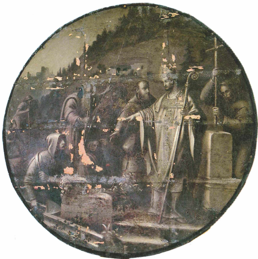
Tafel III: Baubeginn der Salzburger Peterskirche (man beachte die Arbeitsgeräte). Dieses Bild wurde jahrzehntelang für die Ankunft Ruperts in Juvavum gehalten (Foto: Dommuseum/Kral).
