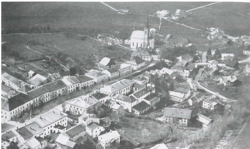
Abbildung 5: Auf dem Luftbild aus dem Jahr 1930 sieht man in der Bildmitte das große Brauereigebäude Karlbräu mit zwei Schloten (1983 demoliert). Foto: Luftaufnahme 151 der Österreichischen Fliegerschule Salzburg.
