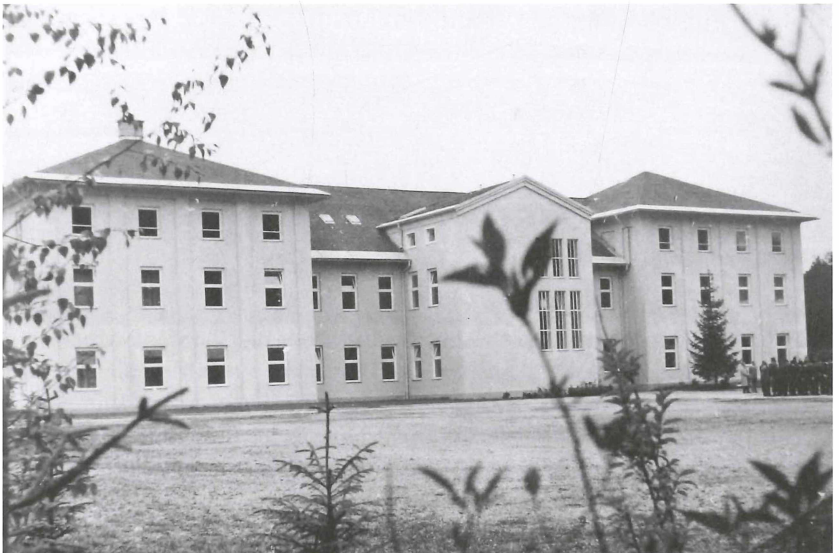
Abb. 9: Das Kommandogebäude der Riedenburg-Kaserne in den 1960er-Jahren. Foto: Salzburger Wehrgeschichtliches Museum (SWGm) mit freundlicher Genehmigung: Militärkommando Salzburg.
