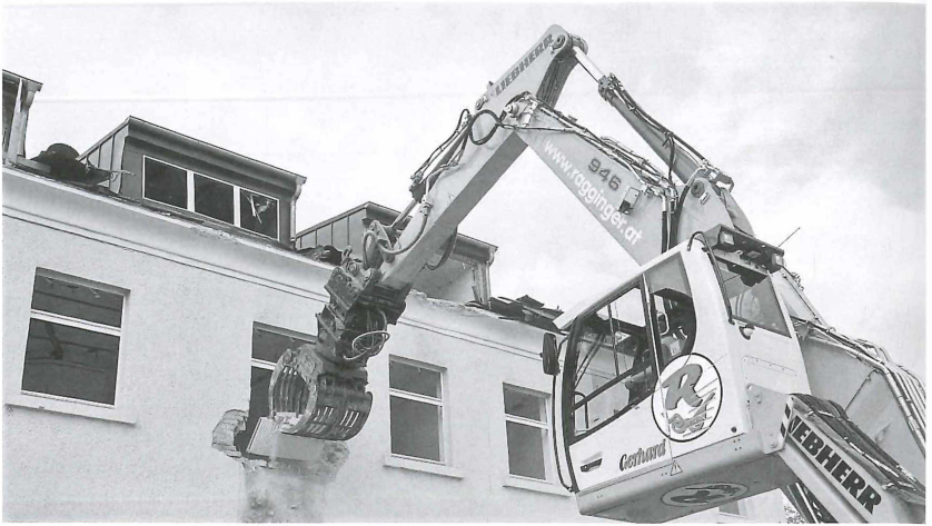
Abb. 10: Abrissarbeiten in der Riedenburger-Kaserne im Juni 2016. Foto: Salzburger Wehrgeschichtliches Museum (SWGGM).
