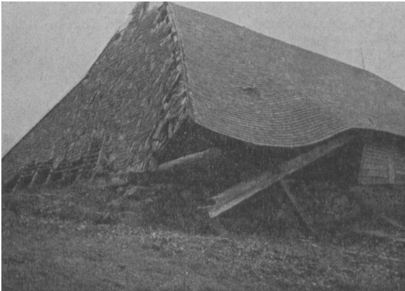
Von der Lawine eingedrückte Zastler-Viehhütte. Inzwischen durch zwei Winter viel weiter zerstört. Aufnahme: Prof. Dr. Lorbeer.
