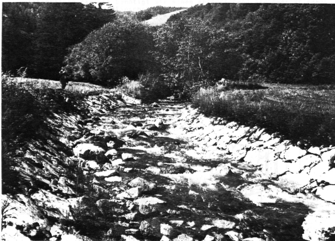
Abb. 2: Ansätze zur naturnahen Verbauung eines Baches: Lachtal, August 1974. Foto: S. Plank.
