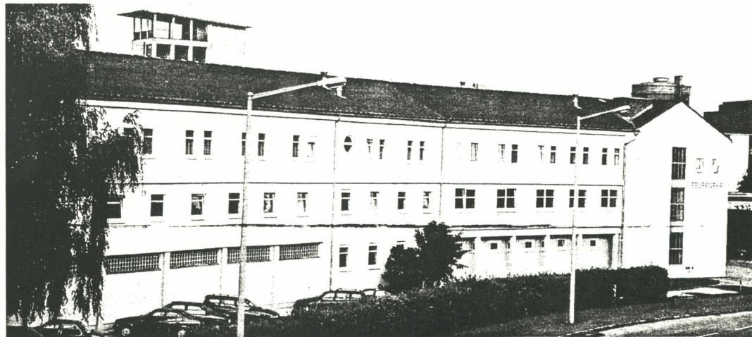
Im aufgestockten Muldenstraßenrakt ist nunmehr ausreichend Platz für den Dienstbetrieb.
