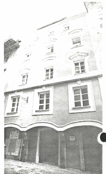
Eine gelungene Generalsanierung beim Altstadthaus Hofgasse 10. Fotos: Herzenberger
