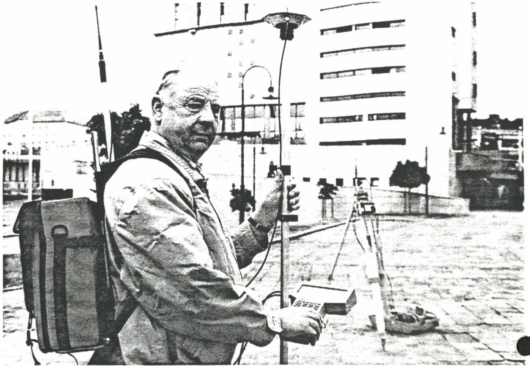
Die Satellitenmeßmethode wird von den Mitarbeitern des Vermessungsamtes der Stadt Linz angewendet. So wurde beispielsweise die Umfahrung Ebelsberg vermessen.
