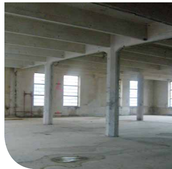
OBERGESCHOSS VOR DER SANIERUNG
