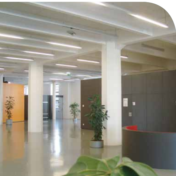
ERDGESCHOSS NACH DER SANIERUNG, EINBAU DER „RAUMBOXEN“
