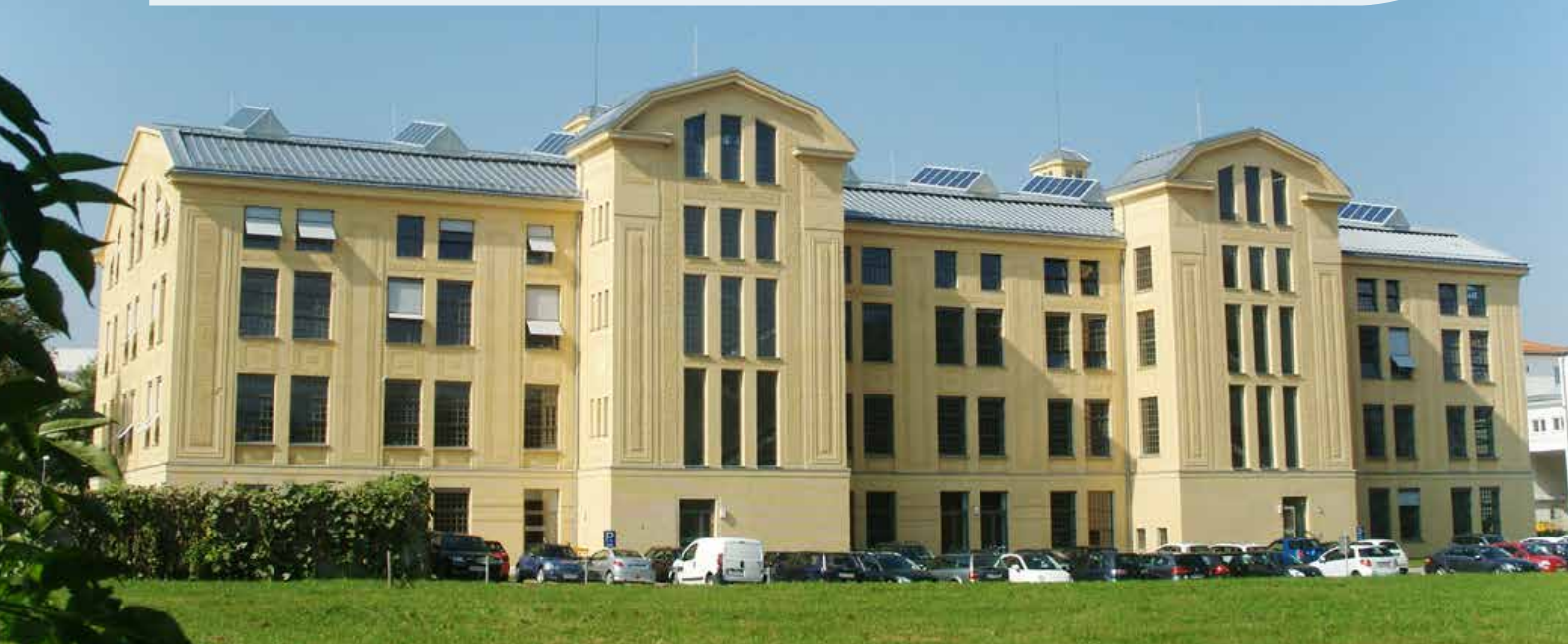
DAS DENK-MAL DIESER AUSGABE: DIE EHEMALIGEN „REITHOFFER-WERKE“ IN STEYR, AB SEITE 8
