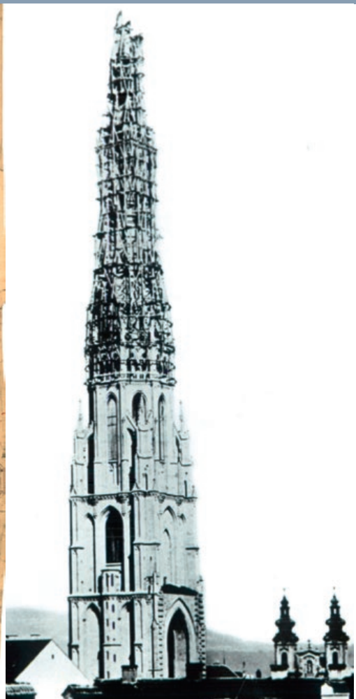
BIS ZUR SPITZE REICHENDES GERÜST AM TURMHELM ENDE SEPTEMBER 1901.
