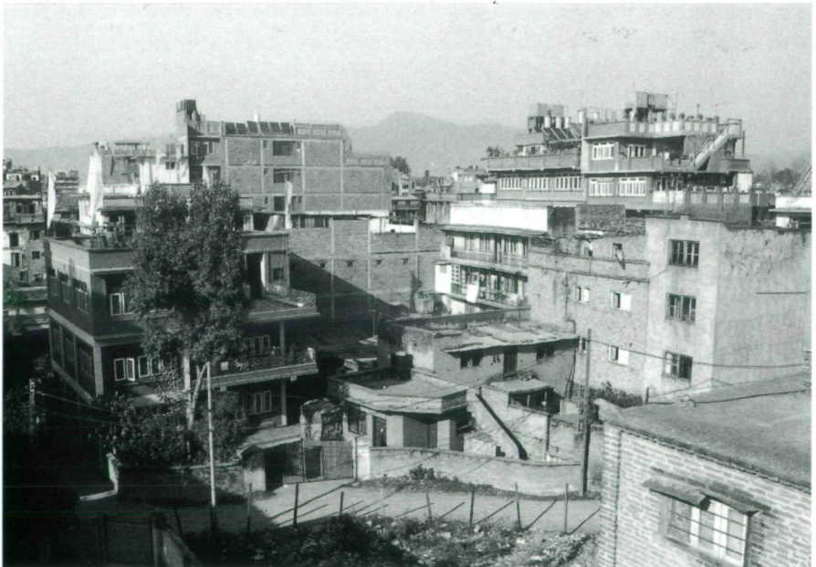
Abb. 4: Unkontrollierte Neubautätigkeit im Stadtteil Thamel (Katmandu).
