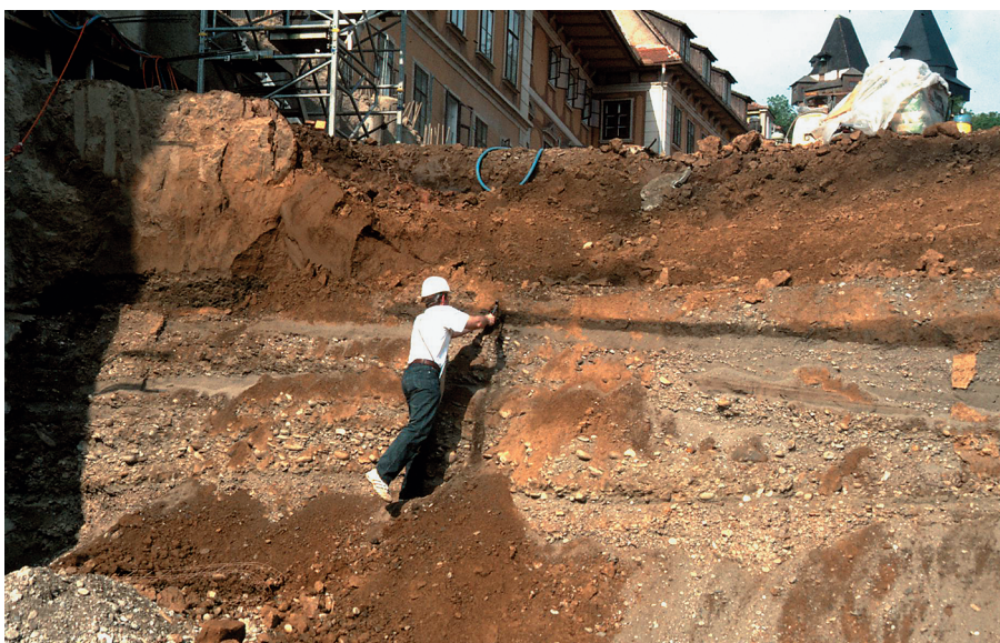
Abb. 3: Anmoorhorizont im oberen Bereich des Schotterpaketes als Rest einer Stillwasserbildung im Randbereich eines Mur-Mäanders am Ostrand der Baugrube Karmeliterplatz. Bog horizon in the upper part of the gravel unit. It is the rest of a still water formation in the distal parts of a Mur meander along the eastern margin of the construction site at Karmeliterplatz.
