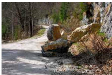
Abb. 19: Zur Seite geräumter Felssturz auf die Klausgrabenstraße. Fig. 19: Klausgrabenstraße with rock fall.
