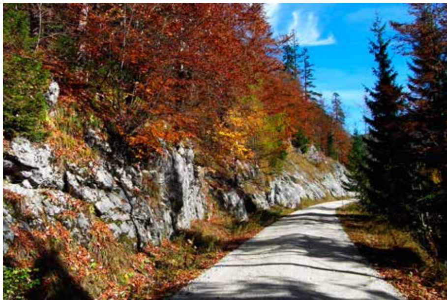
Abb. 18: Bartleck ober dem Klausgraben. Fig. 18: Bartleck over the Klausgraben.
