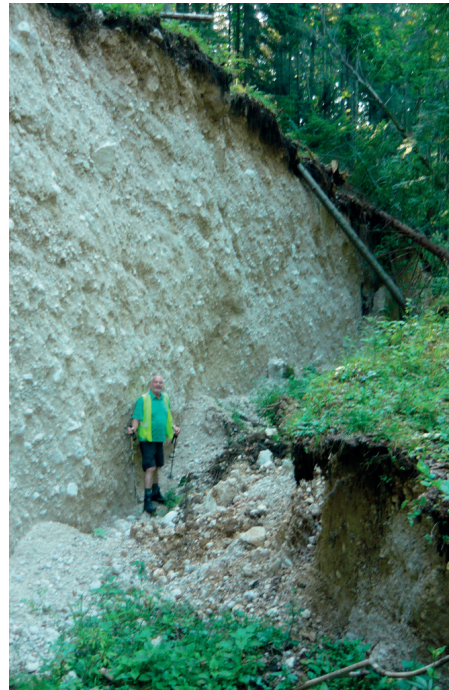
Abb. 6: Hauptanbruchfläche der Rutschung am Holzwerkgraben.
