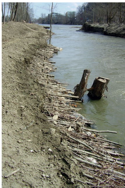
Abb. 13: Weidenspreitlagen am Murofer bei Weitersfeld (Foto: A. Drescher 2006-04-02)
