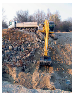
Abb. 6a (links): Entfernung des Blockwurfs; © Nationalpark Donau-Auen GmbH). 6b (rechts): Naturnahes Ufer am Thurnhaufen wenige Monate nach der Entfernung der Ufersicherung (Foto: A. Drescher 14. Oktober 2006)
