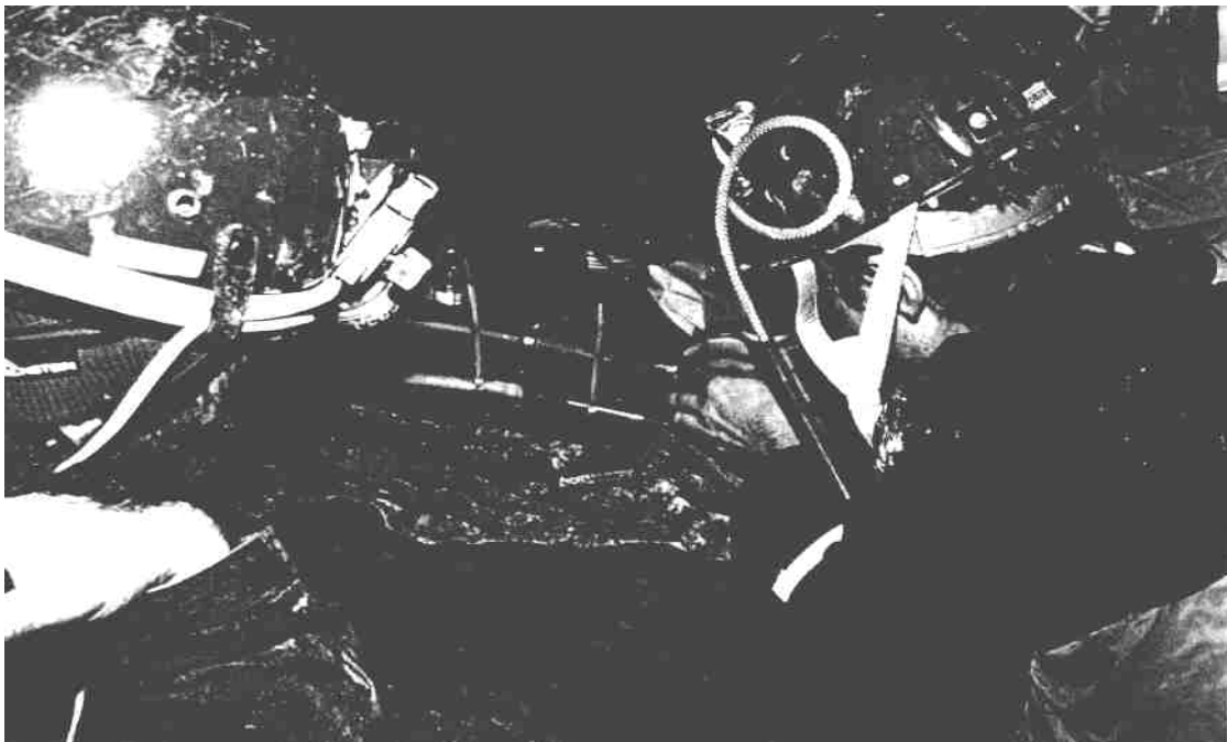
Abb. 9 Reparaturarbeiten an der Wasserstandsmeßsonde am Vordersee am 01. 12.1993
