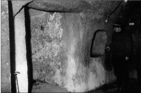
Abb. 8: Feichtnerkeller. – Abzweigung eines heute verstürzten Seitenstollens im Vorraum gleich hinter dem Portal. Foto: E. FRITSCH, 2003.
