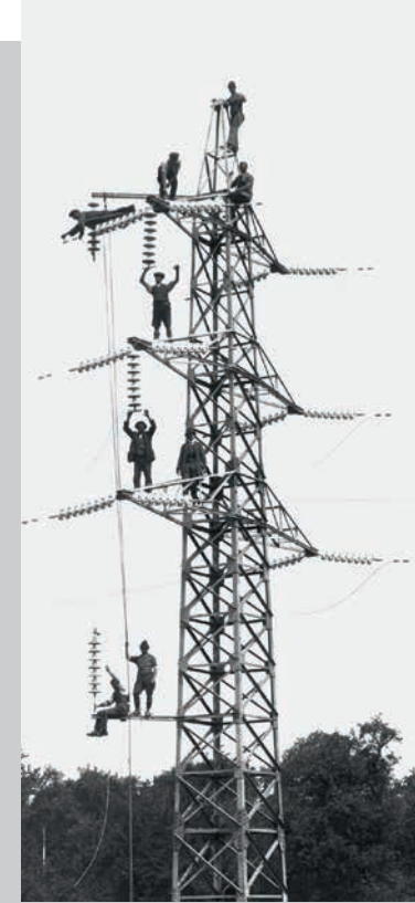
Errichtung einer Hochspannungsleitung beim Mühlekraftwerk Partenstein
