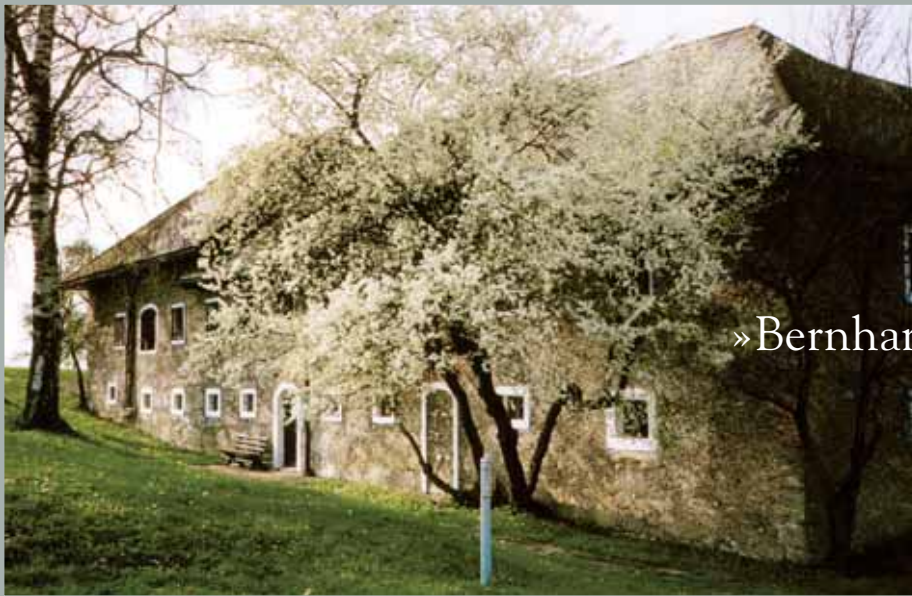
Thomas Bernhards Wohnhaus in Obernathal bei Ohlsdorf, Oberösterreich. © Thomas Bernhard Nachlassverwaltung GmbH
