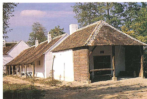
Schmiede mit Beschlagstand aus Palzenthal
