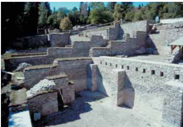
Abb.9: Zu überdachender Verwaltungstrakt – konservierter Mauerbestand (Foto: H. Dolenz)
