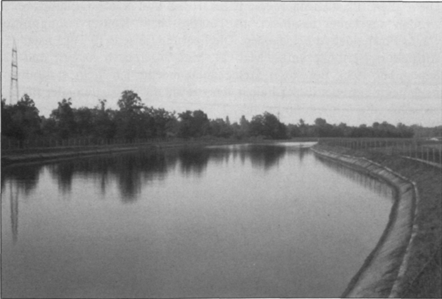
Abb. 1: Der als „biologische Barriere“ wirksame ESG-Oberwasserkanal.
