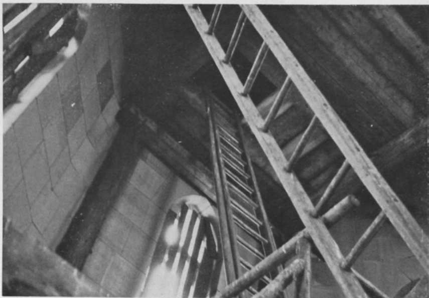
ABBILDUNG 3: Blick gegen den Dachraum im Turm des Neuen Domes.
