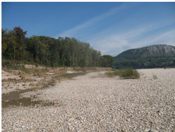
Wasser am Böschungsfuß bei höherem Wasserstand (01.10.2007)
