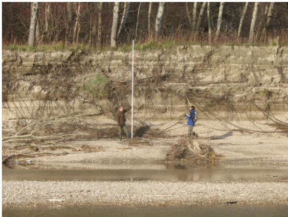
Erosion an der Waldkante – Wurzelvorhang [Foto: kartierung 73.jpg]
