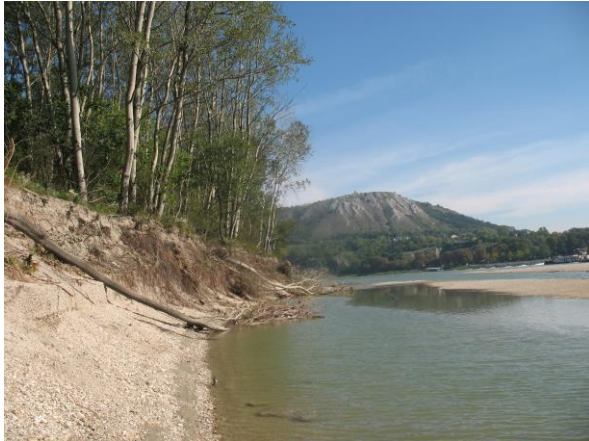
Erosion an der Waldkante – hängende Bäume, Wurzelvorhang [Foto: IMG_1713.jpg im Ordner 07 10 01!!!]
