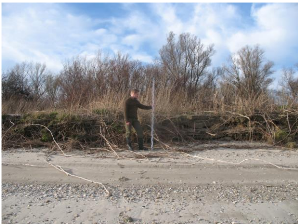
Bewachsene lehmige Böschung [Foto: kartierung 153.jpg]
