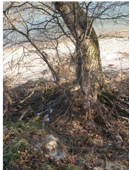
Bereits Freilegung der Wurzeln bei auf der Böschung stehendem Baum
