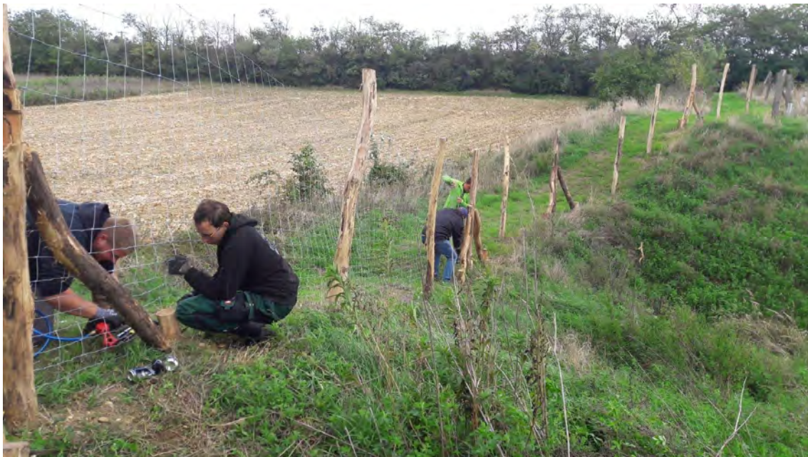
Abbildung 79. Fertig gestellte Einzäunung des Grundstücks (Foto: Horvath)
