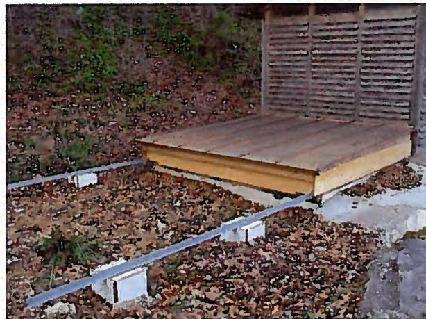
blech ausgewählt. Die ganze Konstruktion ist auf Laufschienen montiert, da zum Wechseln der Toiletteneinheit das Dach zur Seite geschoben werden muss.
