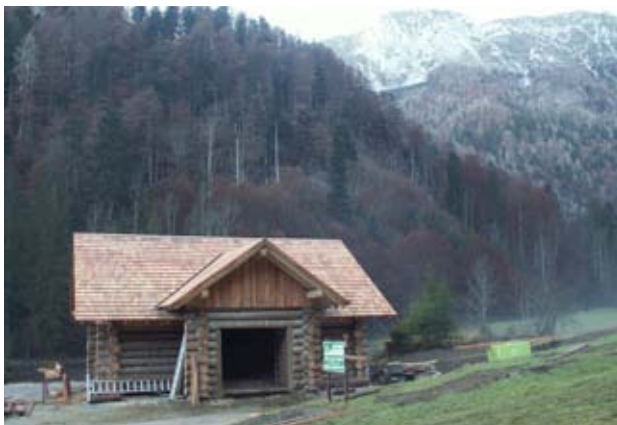
Neuer Futterstadel kurz vor der Fertigstellung.
