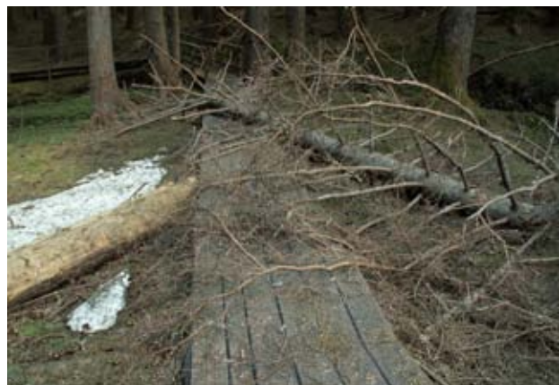
Die Reparatur von Besuchereinrichtungen nach Winterschäden wird von Mitarbeitern der ÖBf und der Nationalpark Kalkalpen GmbH bewerkstelligt.
