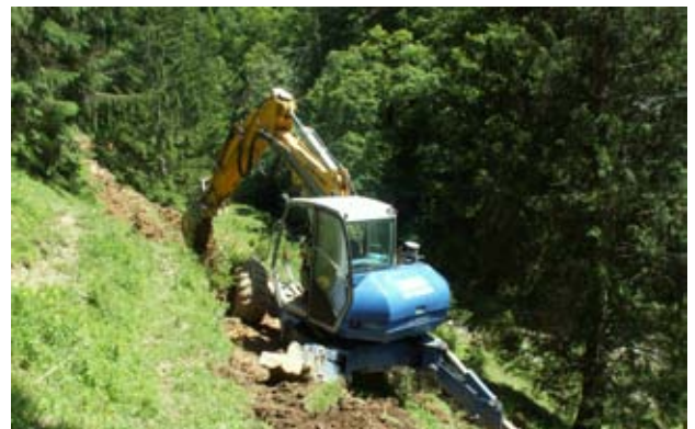
Grabarbeiten zur Verlegung der neuen Wasserleitung.
