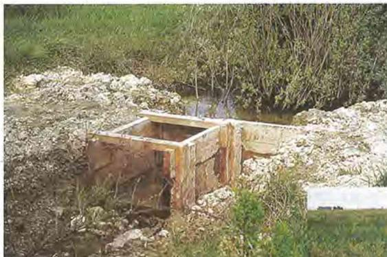
Mit dieser einfachen Holzkonstruktion kann das Wasserniveau in einem Entwässerungskanal beliebig reguliert werden.
