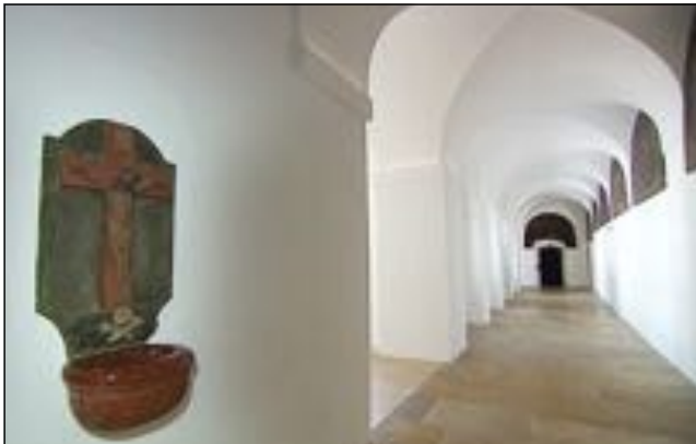
Der Boden des westlichen Kreuzganges wurde mit Kehlheimerplatten neu verlegt.
