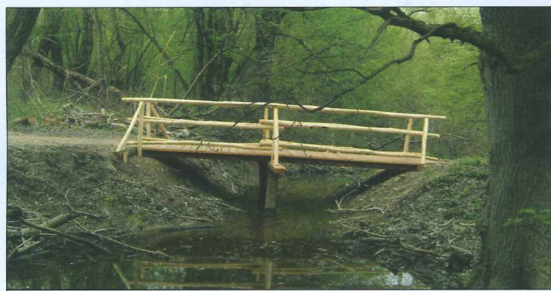
NEUE BRÜCKEN ERSETZEN DIE TRAVERSEN IN DER ORTHER AU
