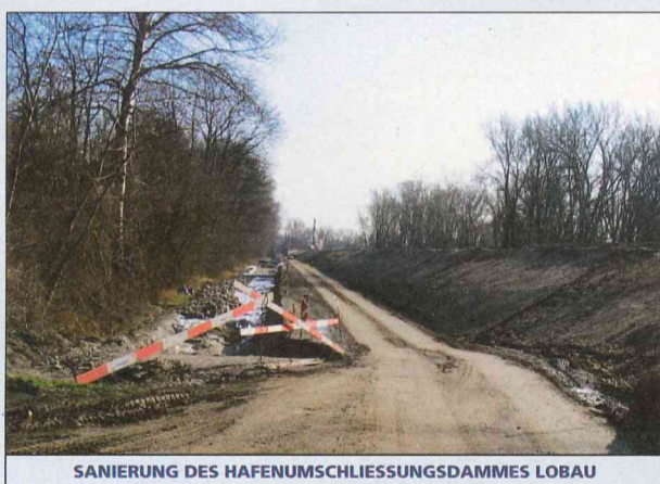
SANIERUNG DES HAFENUMSCHLIESSUNGSDAMMES LOBAU
