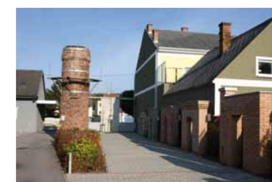
■ Dorferneuerungsprojekt Neutal – Zubau MUBA
