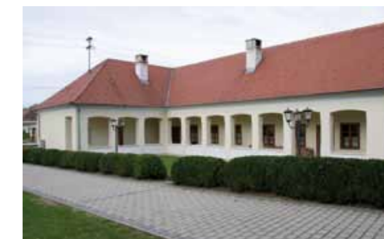
■ Dorferneuerungsprojekt Unterloisdorf – Dorfzentrum
