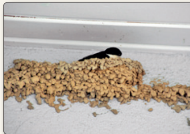
Mehlschwalben bauen ihre Nester gerne an unter Dachvorsprüngen liegenden Mauerteilen von Gebäuden.
