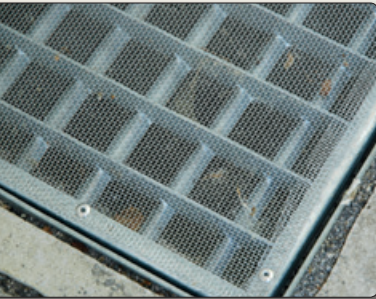
Mit engmaschigem Drahtgitter abgesicherter Lichtschacht
