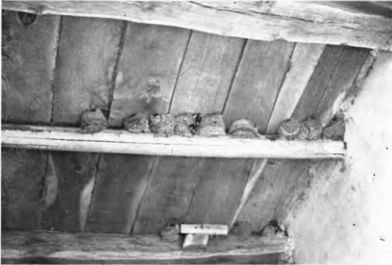
Abb. 2: Die Nester an den Deckenbalken.
